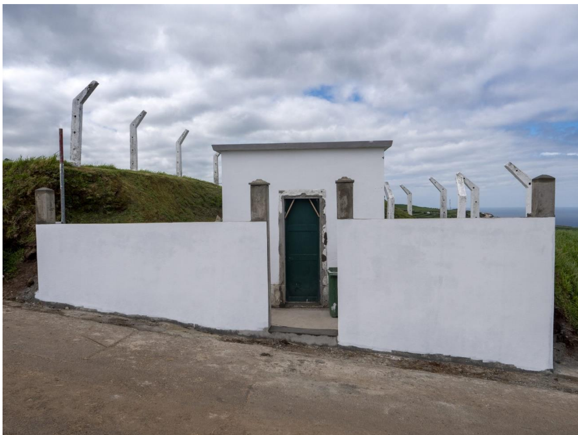
Intervenção no reservatório de São Pedro Nordestinho
