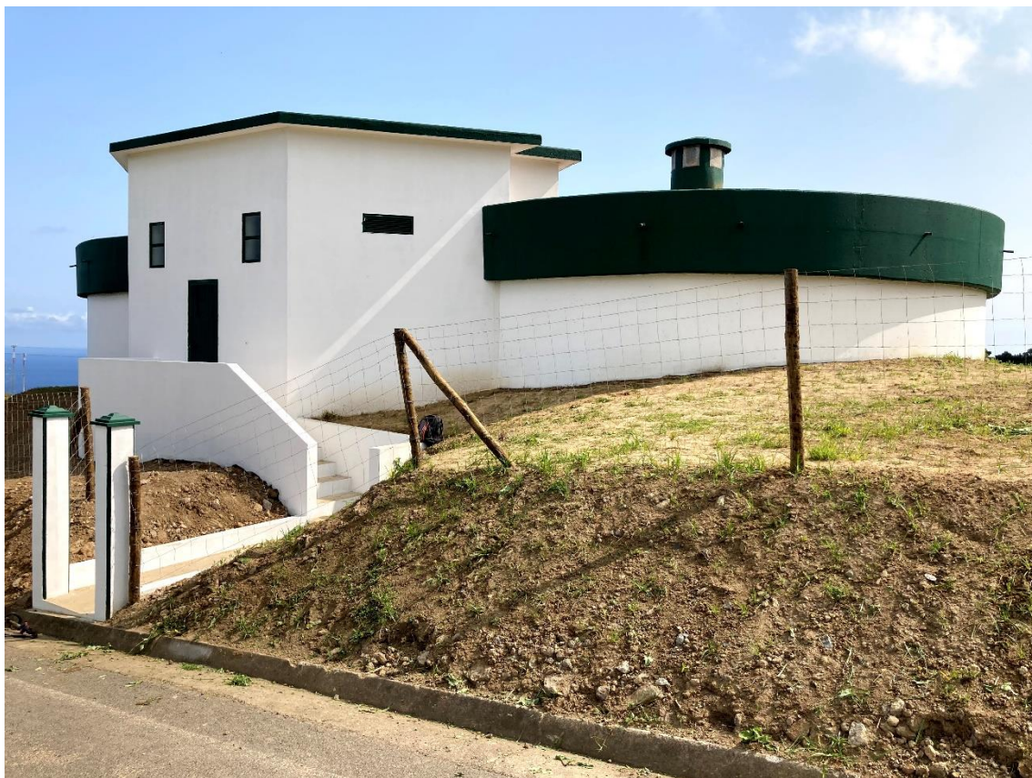
Intervenção no reservatório da Achada
