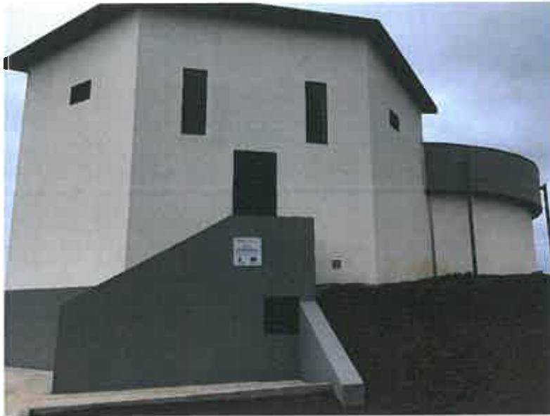
Foto novo reservatório construído na Freguesia da Fazenda
