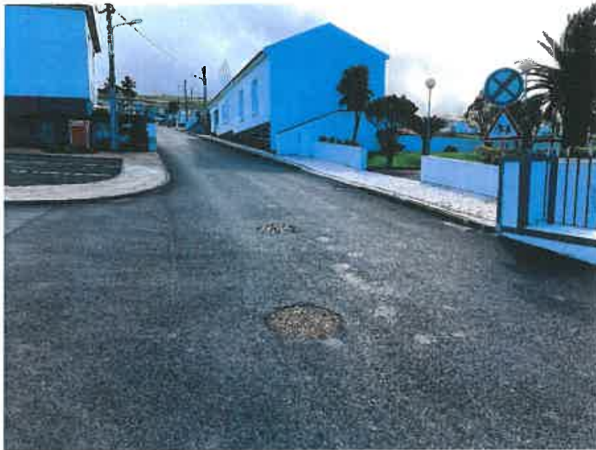
Foto arruamento intervencionado
