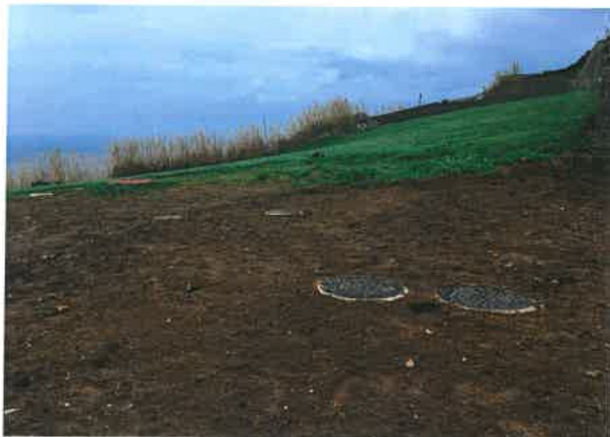
Foto fossa séptica
